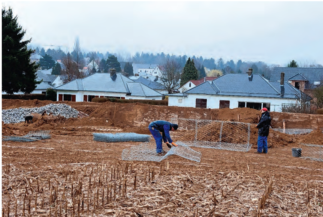
Werkmannen leggen de buffervijver aan. Foto Baert
