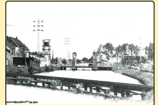
In 1942 werd tijdens de voorbereidende werken voor de vaste brug over het kanaal een tweede tijdelijke oversteek voor de tram aangelegd vanaf het goederenspoor in afwachting van de vaste aparte trambrug.
