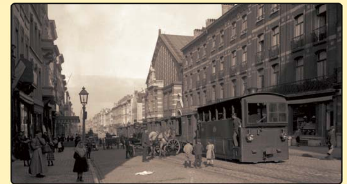
Het eindpunt van de lijn (1905). Aan de "Hallen van Schaarbeek" werden de goederen overgeladen op karren om verder hun koopwaar te slijten in het Brusselse. Er werd hier dagelijks een 20.000 liter melk aangevoerd. Merk op dat hier enkel goederenwagons te zien zijn. Passagiersvoertuigen werden pas later ingevoerd.
