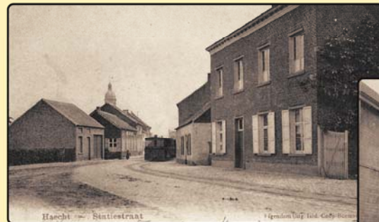
De stoomtram vanuit Haacht-Dorp neemt de bocht richting de rangeersporen aan de Statiesstraat. De woning rechts was deze van voormalige burgemeester De Veuster.
