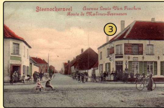
Kruising Van Frachenlaan met de Haachtsesteenweg. Vooraan bemerkt men de transporen. Zicht richting Steenokkerzeel dorp.
