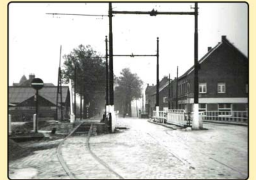
Na de sabotage van de toenmalige draaibrug in 1940 werd voor de tram naast de vroegere brug een tijdelijk spoor aangelegd.
