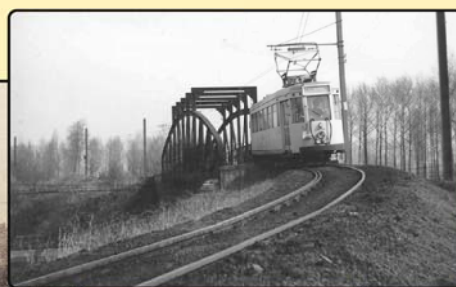
Bij de elektrificatie van de lijn werd de bovenkant van de brug verhoogd om de bovenleidingen te kunnen plaatsen.
