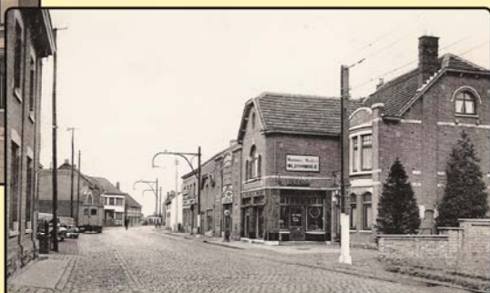
Na WO 2, let op de elektrificatie (zicht richting Haacht-Dorp).
