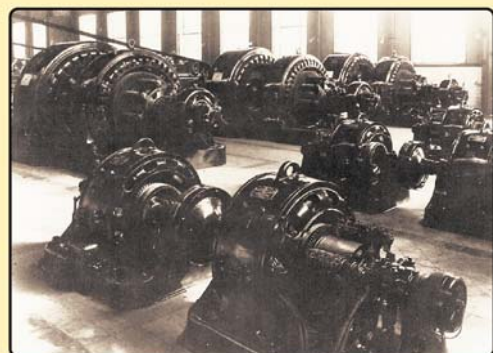
Voorbeeld van de motorgeneratoren
