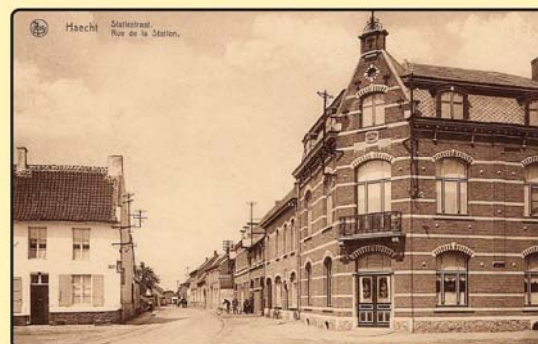
Zicht vanop het marktplein, richting Statiesstraat. Het gebouw rechts is heden een Delhaize grootwarenhuis, links nu Kruidvat. Onderaan de tramsporen.
