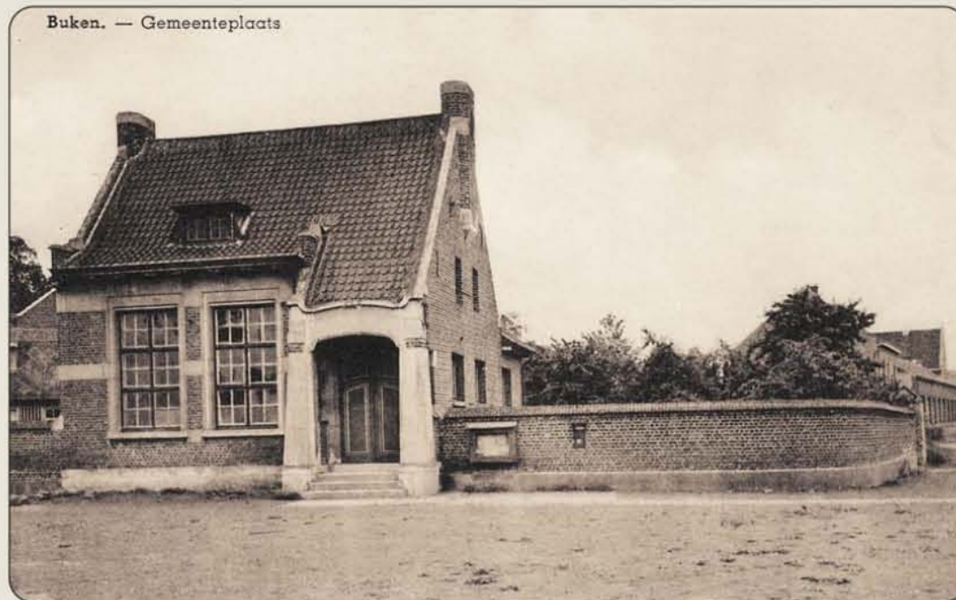
Gemeentehuis van Buken dat op de hoek van de Leuvensesteenweg en de Haachtstraat stond en is afgebroken.
