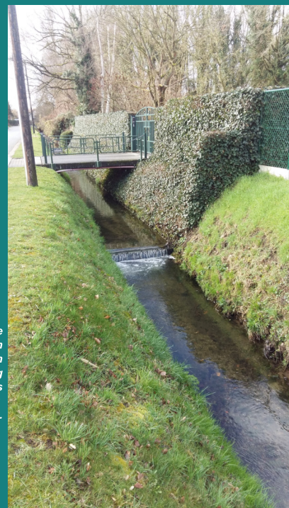
Molenbeek herlegd langs de Notelarendreef en in de jaren 1980 gerecalibreerd met een verdiept trapeziumvormig dwarsprofiel. De watervalletjes zijn een indicatie van het grote verval van de beek.
